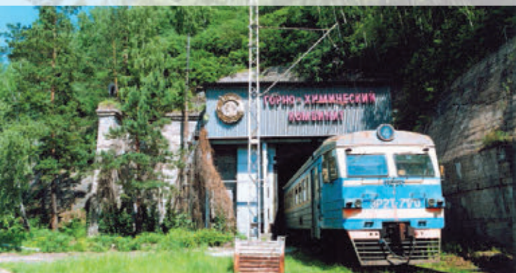
В подземный ГХК (ЗАТО Железногорск) рабочие заезжают на электричке. Комбинат находится в горе, на глубине свыше 200 м
