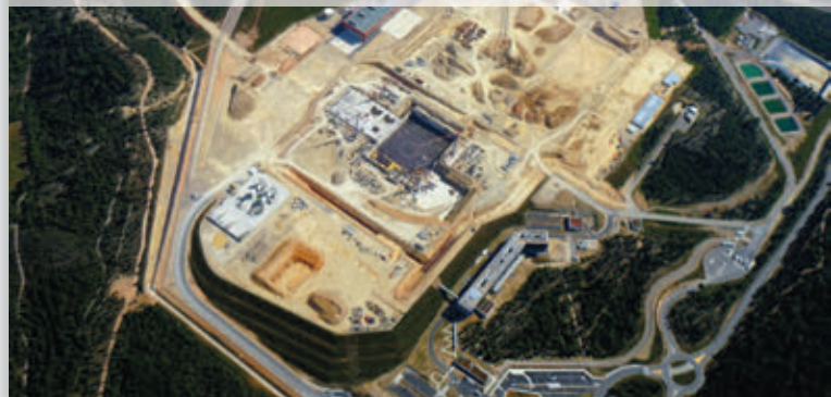
Строительство первого международного экспериментального термоядерного реактора во французском исследовательском центре Кадараш идет полным ходом
